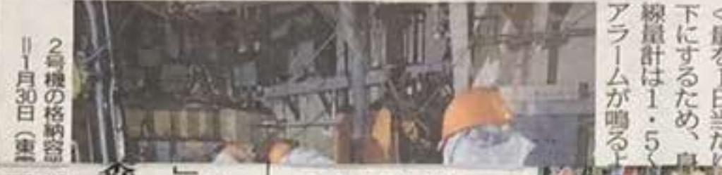
2号機の格納容器。1月30日(東京)
